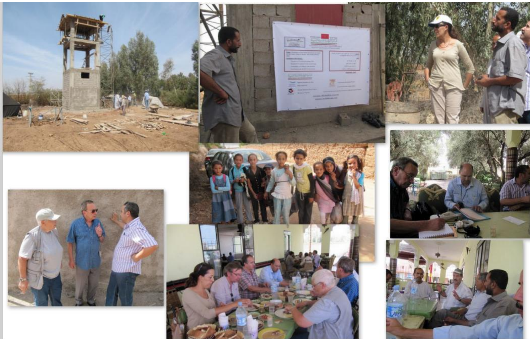
Le 30 Septembre 2011 Visite du Chantier JAIDATE en présence de nombreux responsables dont Fatiha LAYADI (députée), Monsieur Lekbiri ( DPE)... et aussi des enfants du village très intéressés par les visiteurs.
